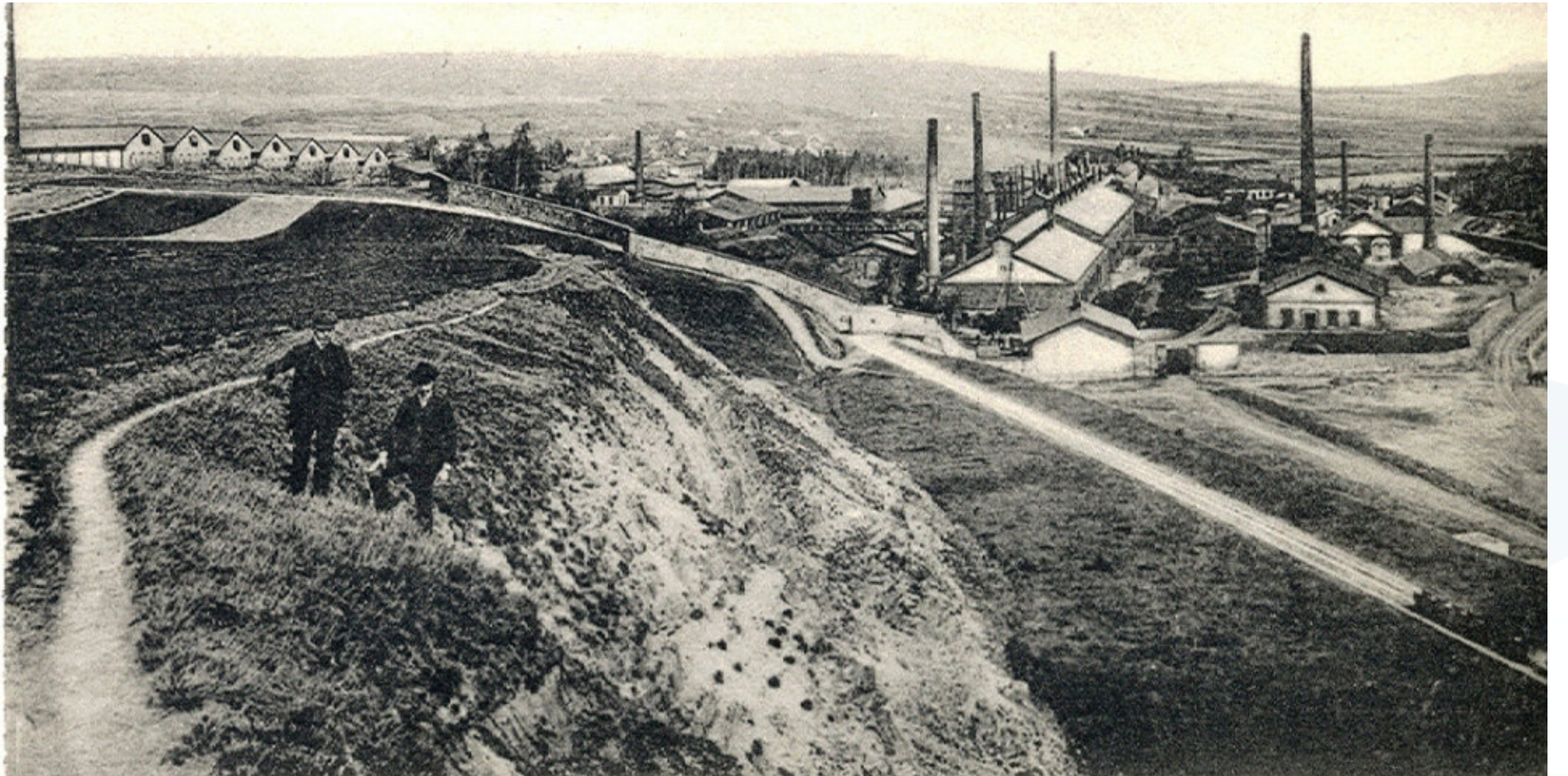
Na obrázku vlevo jsou zaznamenány komory pro sedimentaci prachu
